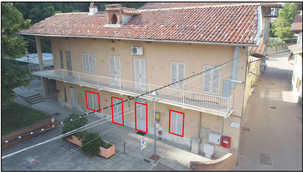
VISTA LATO PIAZZA
